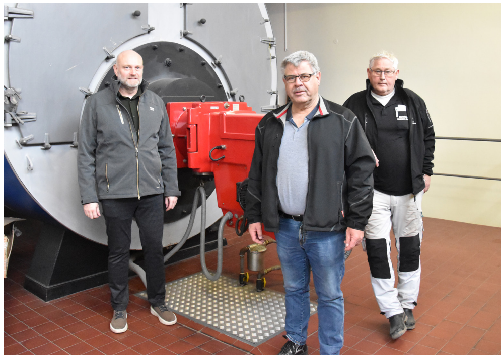
Varmemærkets formand, Fleming Eg Pedersen, til venstre, varmemester Arne Schmidt og Kurt Hansen fra murerfirmaet Hansen og Kruse ved den udtjente oliekedel i lokalerne på Nørregade.
