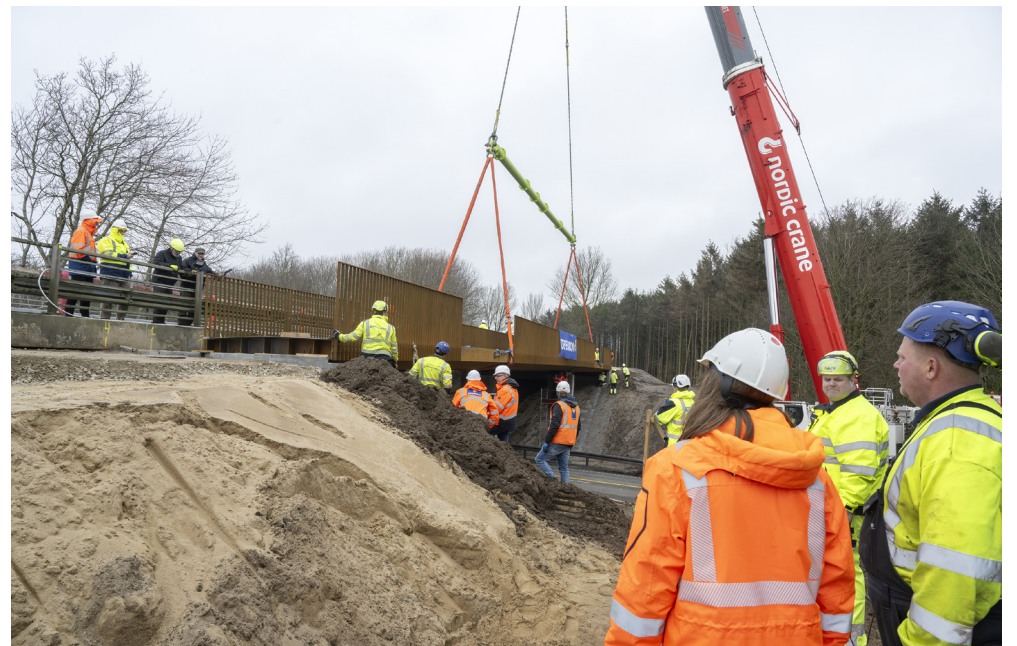
Varde Hovedvej måtte lukkes for al trafik, og en stor kran hentes til hjælp, da det 42 meter lange broelement af stål for et par måneder siden blev løftet på plads. (Foto: Esbjerg Kommune)
